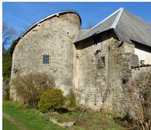
Fig. 58. Montautre, la tour SO et le pignon S du logis O, avec l'arrachement de l'ancienne courtine [cl. ChR 2020].
