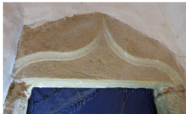
Fig. 55. Montautre, accès à la tour SO, linteau en accolade en remploi [cl. ChR 2021] : les montants sont plus larges que la moulure du linteau.
