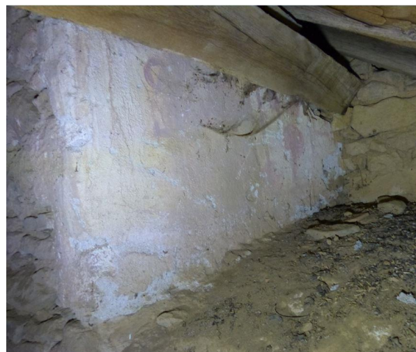
Fig. 52. Montautre, 2 e étage de la tour SO, traces de peintures dans l'embrasure d'une baie [cl. ChR 2021].
