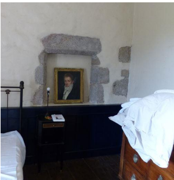
Fig. 31. Montautre, logis E, trace de baie dans l'un des refends de l'extension N [cl. Chr. Rémy, 2020].
