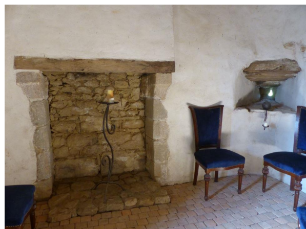
Fig. 56. Montautre, tour SO, chambre du 1 er étage : cheminée et embrasure de tir [cl. ChR 2021].
