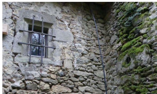
Fig. 63. Montautre, baie chanfreinée et grillée du mur pignon N, donnant sur la chapelle du XVIII e s. [cl. ChR 2021].
