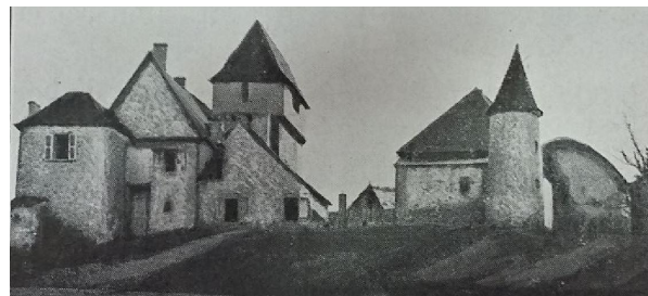
Fig. 68. Montautre, vue du site depuis le N [Drouault 1912] : la toiture du logis O semble interrompue, comme si elle comprenait un séchoir (?).
