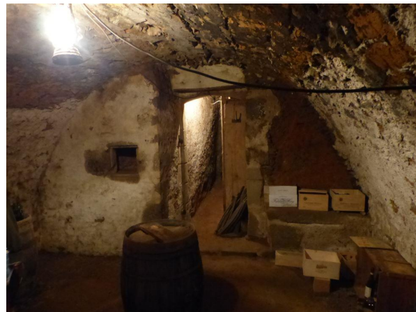
Fig. 32. Montautre, logis oriental, cave creusée dans le substrat et voûtée en berceau [cl. Chr. Rémy, 2020]. Dans le fond, traces de l'ancienne rampe de descente de cave depuis le couloir.
