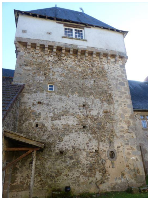
Fig. 34. Montautre, le pavillon du grand degré avant pose de l'enduit. On distingue les boulins d'échafaudage carrés et le trou de tir à redents ovale (v. 1565) ; l'oculus en bas à droite est inséré a posteriori [cl. Chr 2016].
