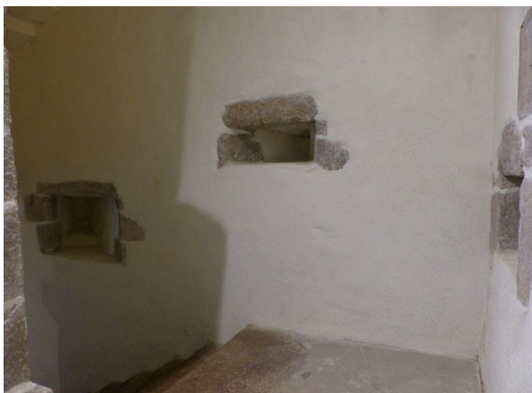
Fig. 35. Montautre, le pavillon du grand degré, embrasures de tir pour mousquets, v. 1565 [cl. ChR 2020].
