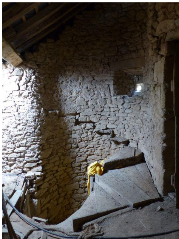
Fig. 54. Montautre, 2 e étage de la tour SO, continuation de la vis en bois vers le 3 e étage, disparu [cl. ChR 2021].
