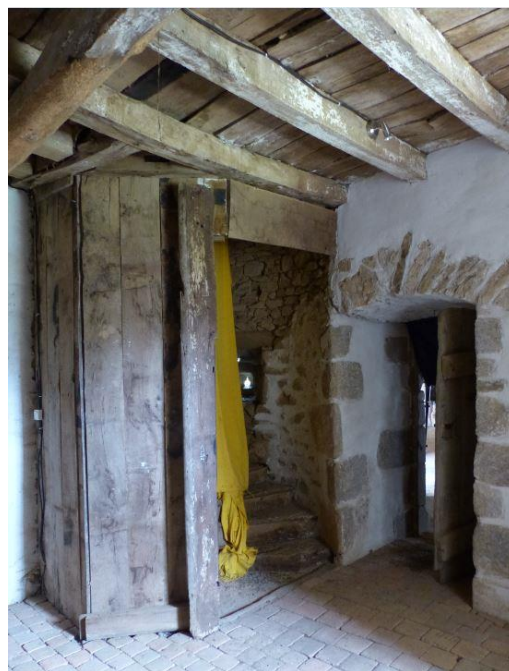
Fig. 53. Montautre, tour SO, 1 er étage, volume de l'escalier en vis de bois et porte d'accès au logis O [cl. ChR 2020].
