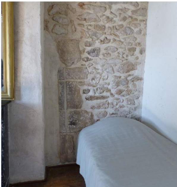
Fig. 30. Montautre, logis E, mur pignon N du logis primitif, traces d'un tore d'angle (jambage de porte ou de cheminée) [cl. Chr. Rémy, 2020].
