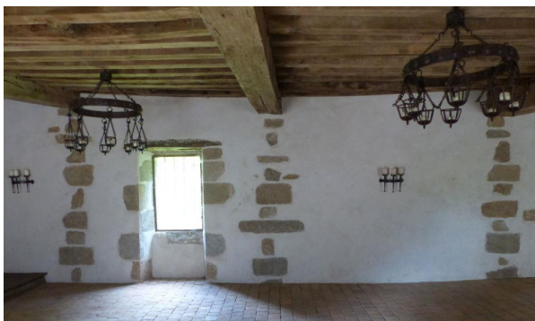
Fig. 50. Montautre, étage du logis O, chaînes verticales portant les poutres [cl. ChR 2021].
