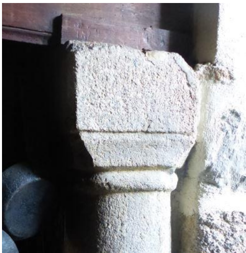
Fig. 28. Montautre, logis oriental, cheminée de la cuisine actuelle, résultant du remploi d'une colonne monolithique antique [cl. Chr. Rémy, 2020].
