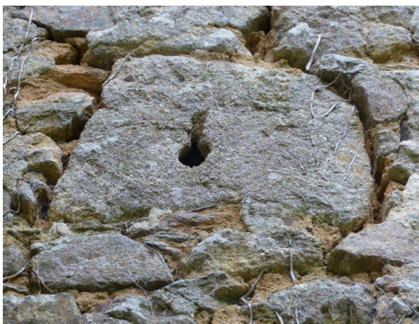
Fig. 57. Montautre, trou de tir dans la tour SO [cl. ChR 2021].
