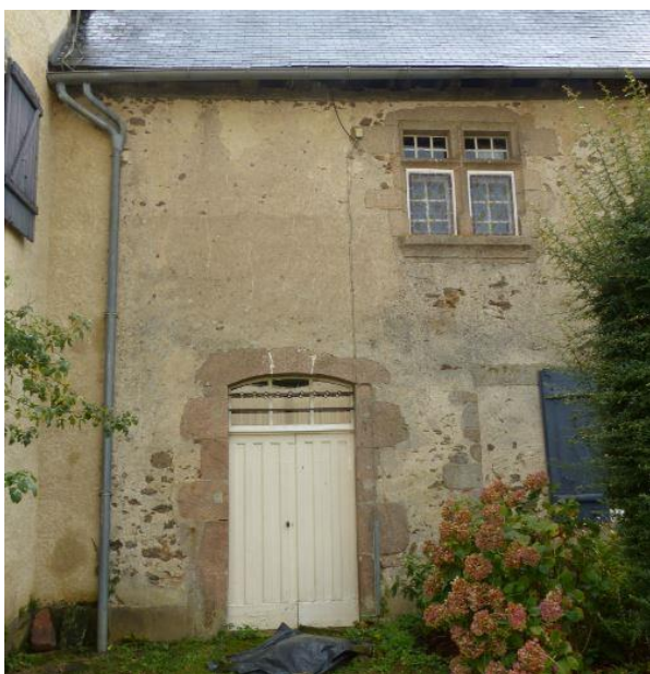
Fig. 24. Montautre, logis oriental, façade O, côté cour [cl. Chr. Rémy, 2020]. La baie à croisée de l'étage est en place ; la porte cintrée du rez-de-chaussée reperçée. On distingue les traces d'une autre ouverture condamnée à droite.
