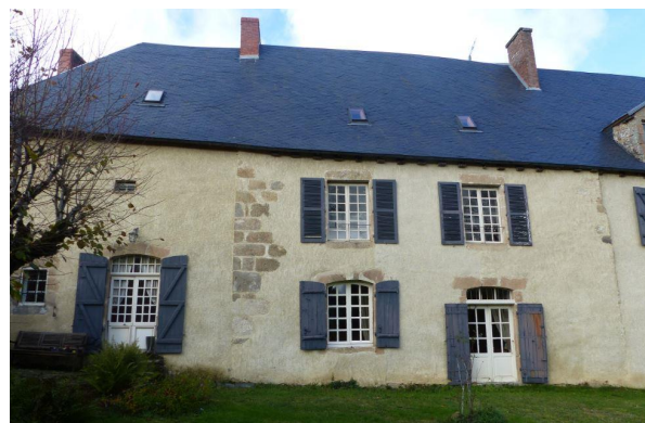
Fig. 26. Montautre, logis oriental, façade E, côté jardin [cl. Chr. Rémy, 2020]. On distingue le chaînage de l'angle S du logis 1460-1470.
