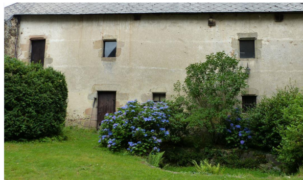
Fig. 47. Montautre, le logis O, portion S vue depuis la cour [cl. ChR 2021].
