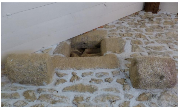
Fig. 27. Montautre, logis E, pignon N, avec petit jour avec trou de grille et deux corbeaux périphériques [cl. ChR 2020].
